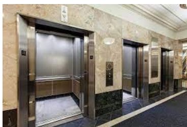
Hình 1.8. Hệ thống thang máy
