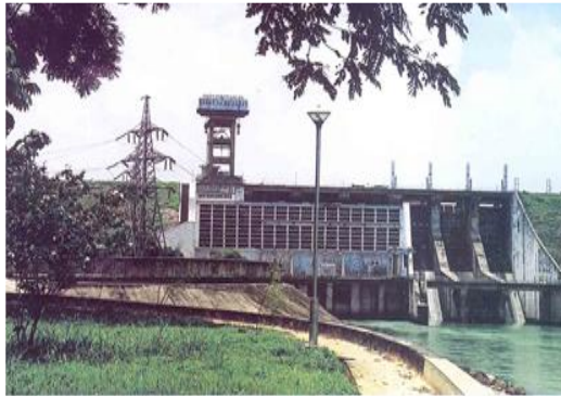
Hình 1.2. Nhà máy thủy điện
