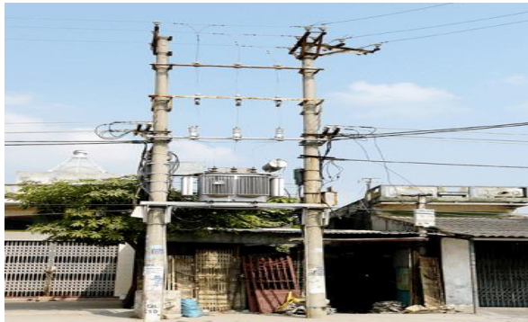
Hình 5.1. Trạm treo S_{dm} \leq 3 \times 75 kVA
