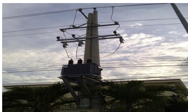
Hình 5.2. Trạm giàn S_{dm} \leq 400 kVA
