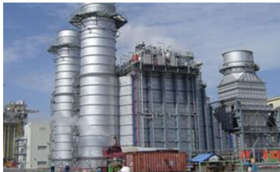
Hình 1.1. Nhà máy nhiệt điện
