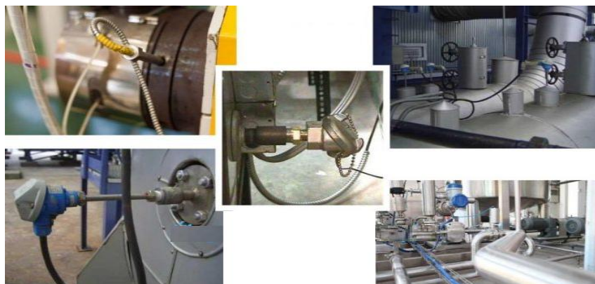
Hình 8.10. Ứng dụng cặp nhiệt điện
