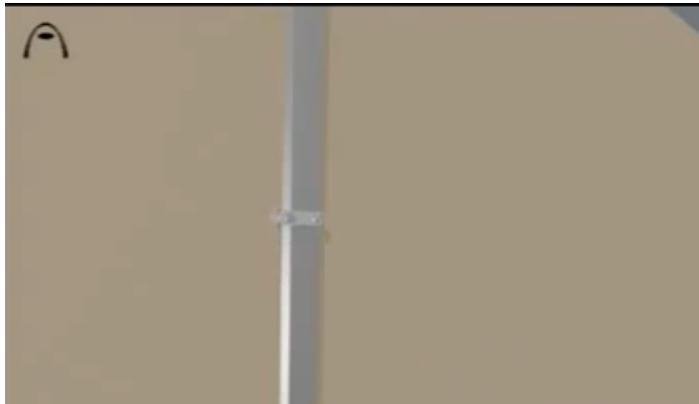
Hình 5-5. Đường dây dẫn sét đứng dọc theo tường
