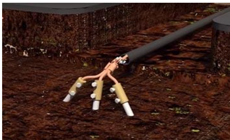
Hình 5-6. Kiểm tra thi công lắp đặt hệ thống chống sét, kiểm tra đóng cọc tiếp địa
