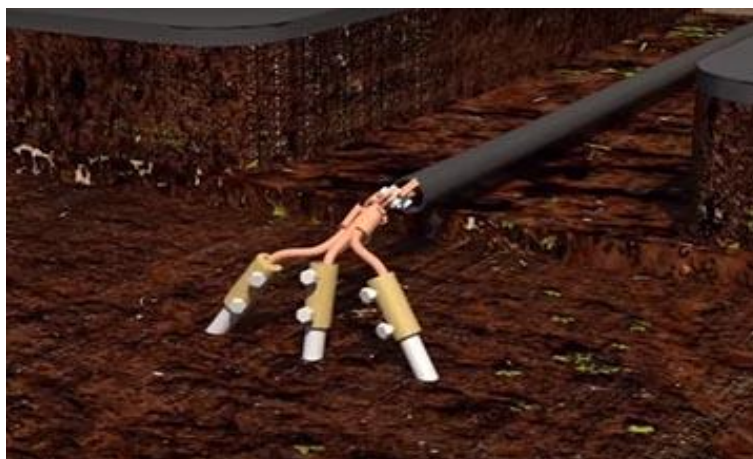
Hình 3.6. Kiểm tra thi công lắp đặt hệ thống chống sét, kiểm tra đóng cọc tiếp địa
