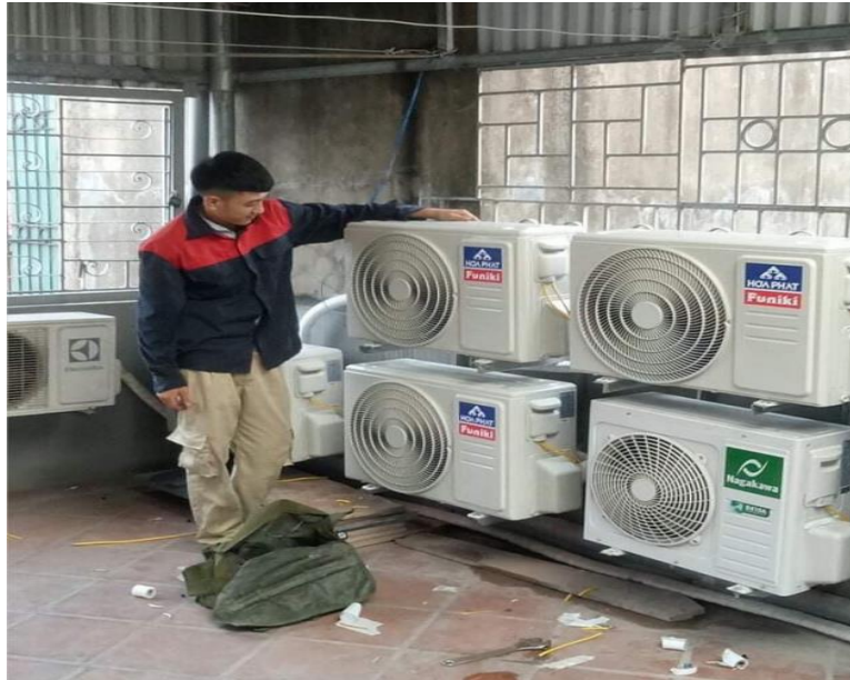
Hình 1.1: Thợ thi công lắp đặt điều hòa không khí cục bộ
