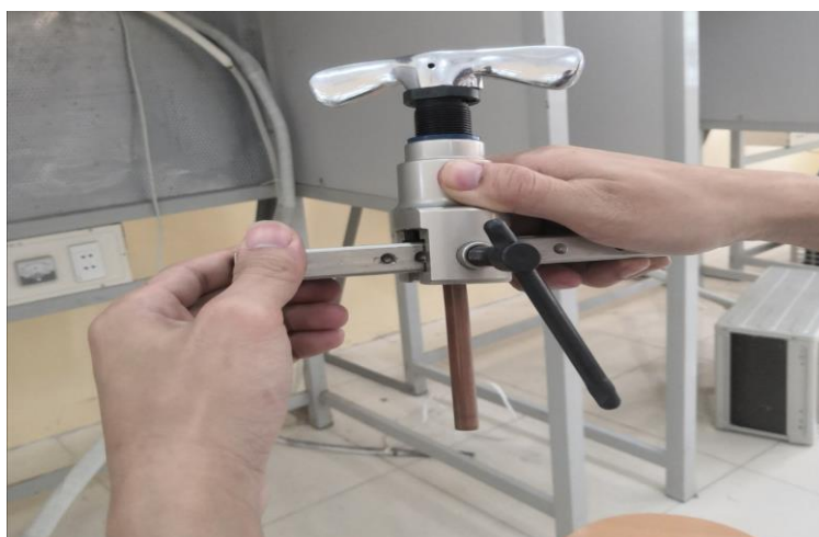
Hình 3.8. Lắp nón loe lên đầu ống
