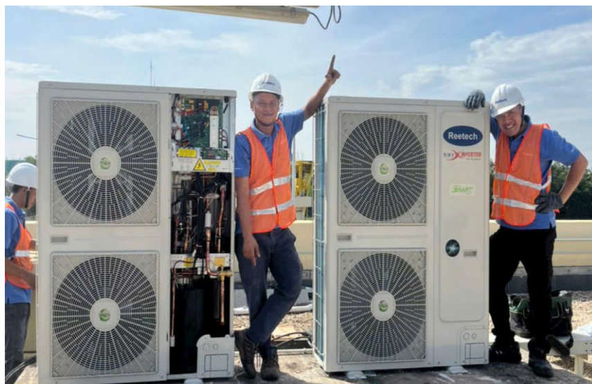
Lắp đặt kết nối cụm máy nén dàn ngưng hệ thống điều hòa không khí
