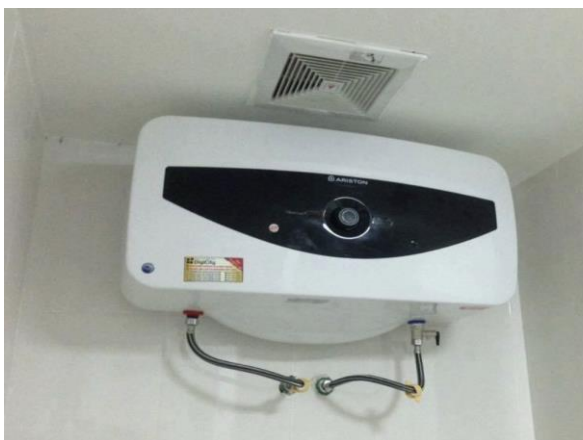
Hình 1.10. Hình dạng thực tế của bình nước nóng gián tiếp.
