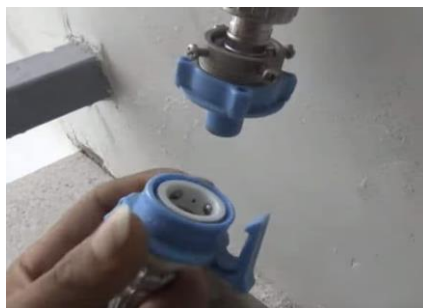
Hình 2.20. Lắp van cấp nước cho máy giặt.
